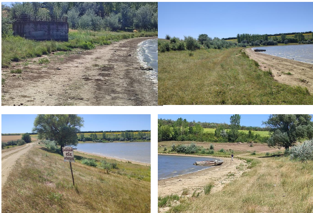
Figura 6. Lacul de acumulare „Ioaniște,, rl.Ungheni (nivelul apei departe de talpa descărcătorului de suprafață).
