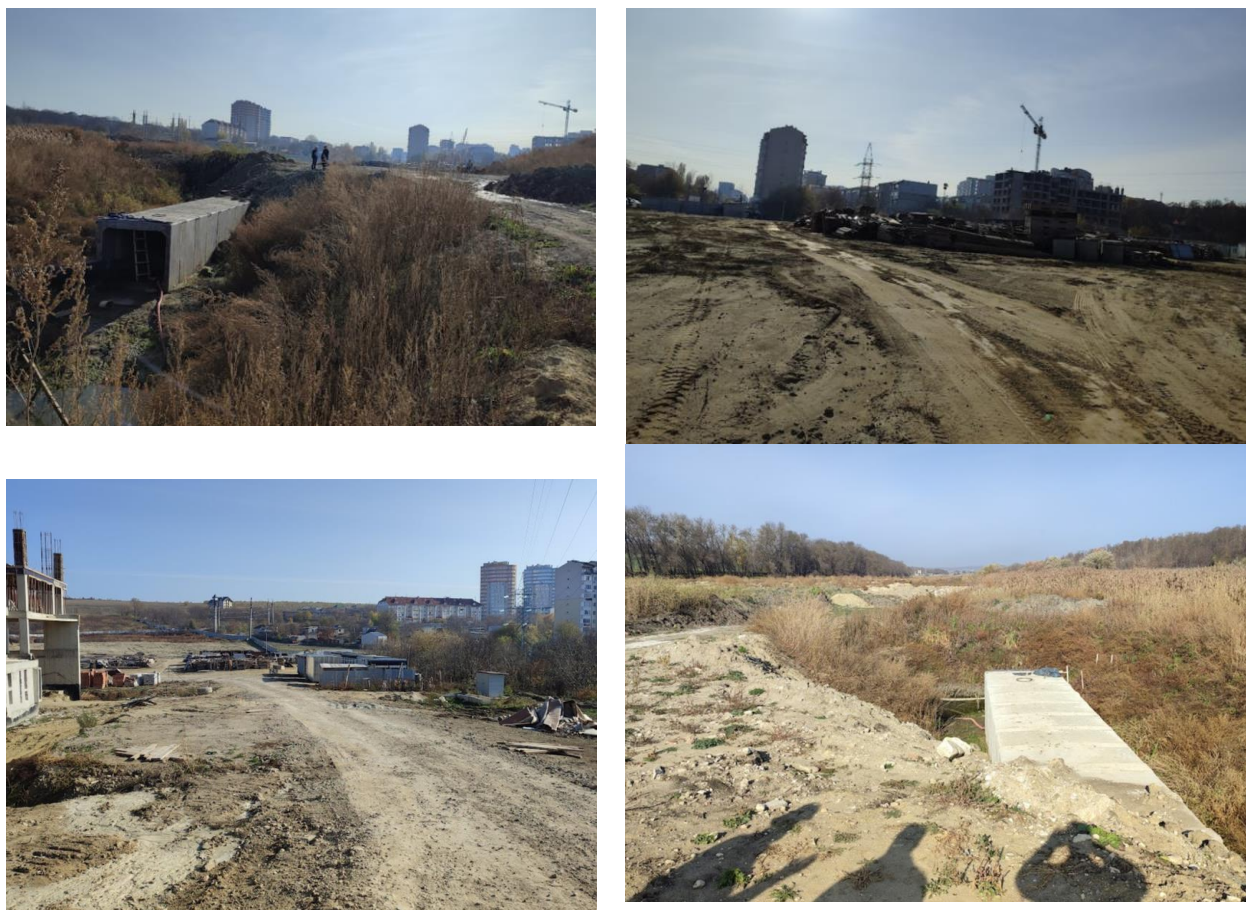
Figura 1. Lacul de acumulare/Construcția Hidrotehnică „ Holbaciha „ (Ceucari) com. Stăuceni mun. Chișinău. Amplasarea geografică. Evoluția lucrărilor.
