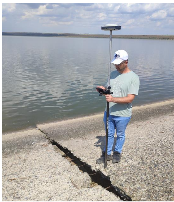
Figura 8. Lucrări topo-geodezice, privind urmărirea comportării în timp a elementelor de construcții și a terenurilor.
