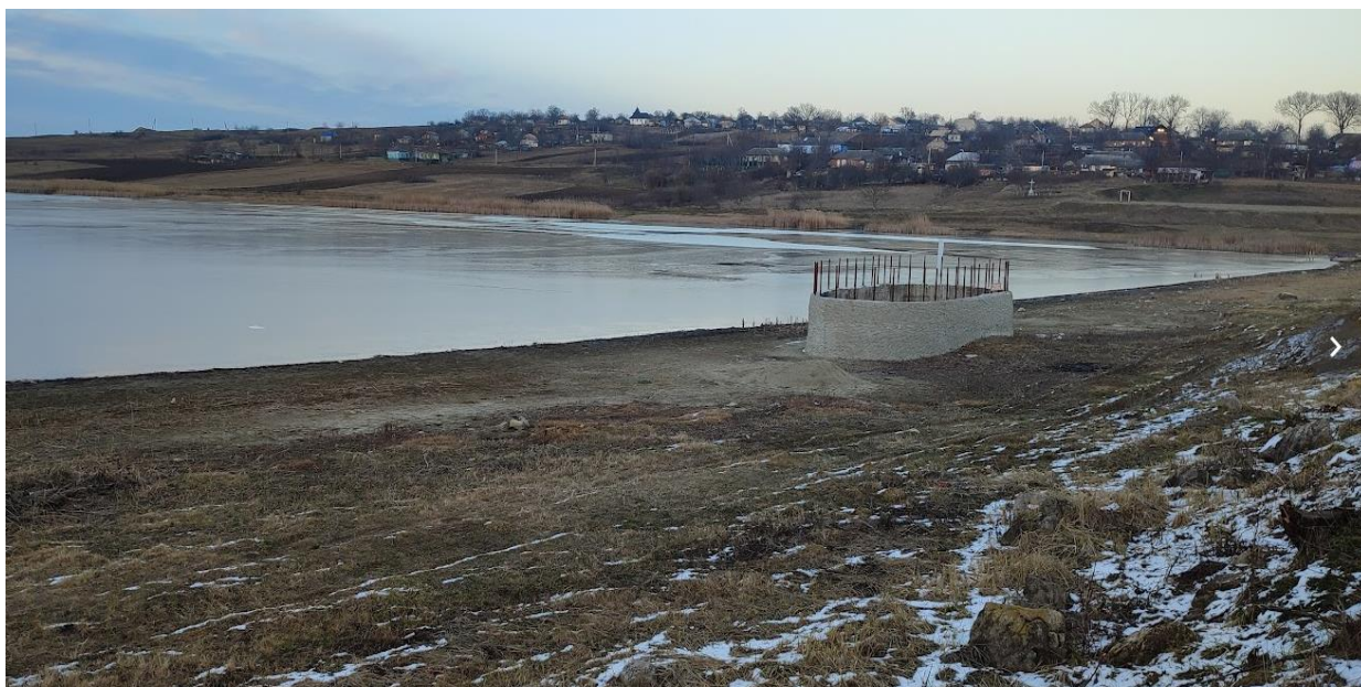
Figura 5. Lacul „Floreni,, rl.Ungheni. Prezența reprezentanților MAIA. Lucrări de consolidare a descărcătorului de suprafață și a terenului aferent.
