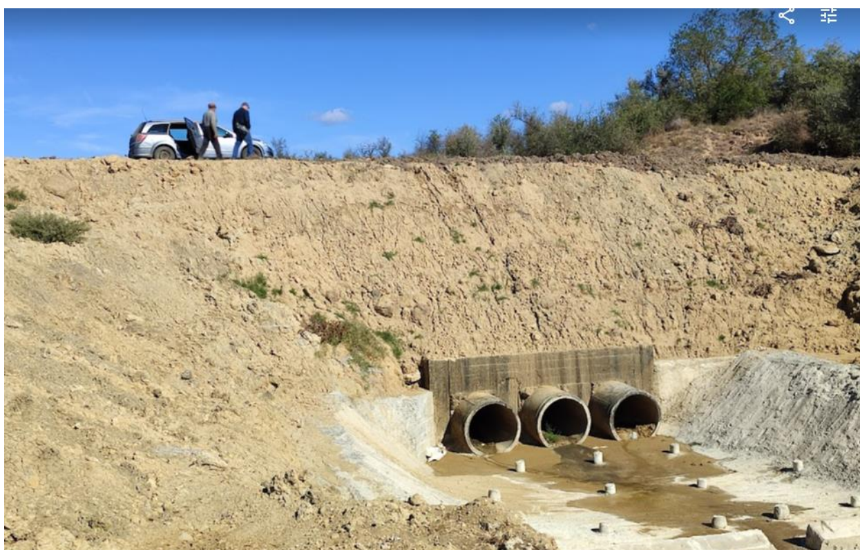
Figura 4. Lacul de acumulare „ Salcia ”, rl.Taraclia. Evoluția lucrărilor, privind reabilitarea descărcătorului de ape de suprafață și integritatea barajului.
