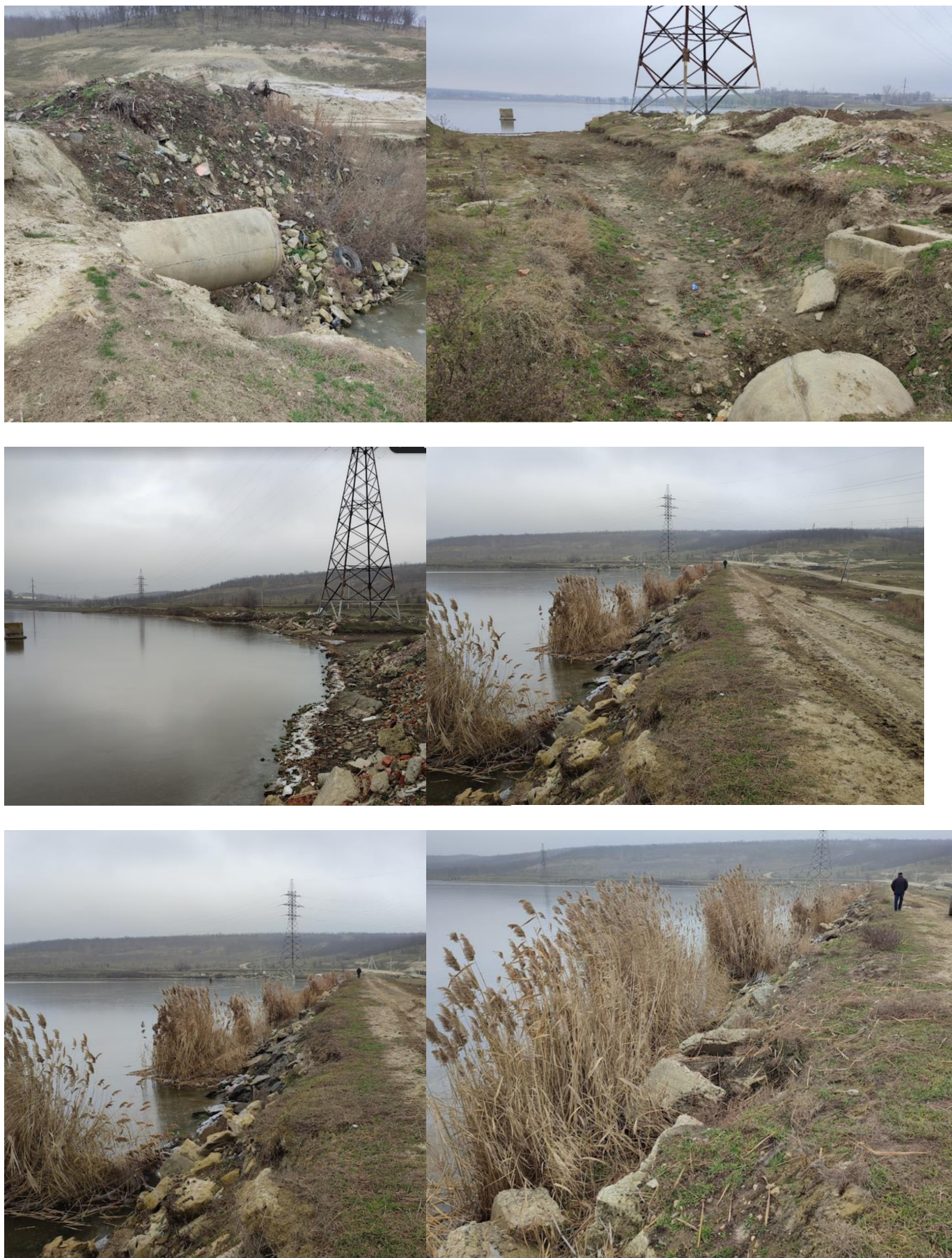
Figura 2. Lacul „Comrat,, rl. Taraclia ( construcția hidrotehnică, barajul ),
